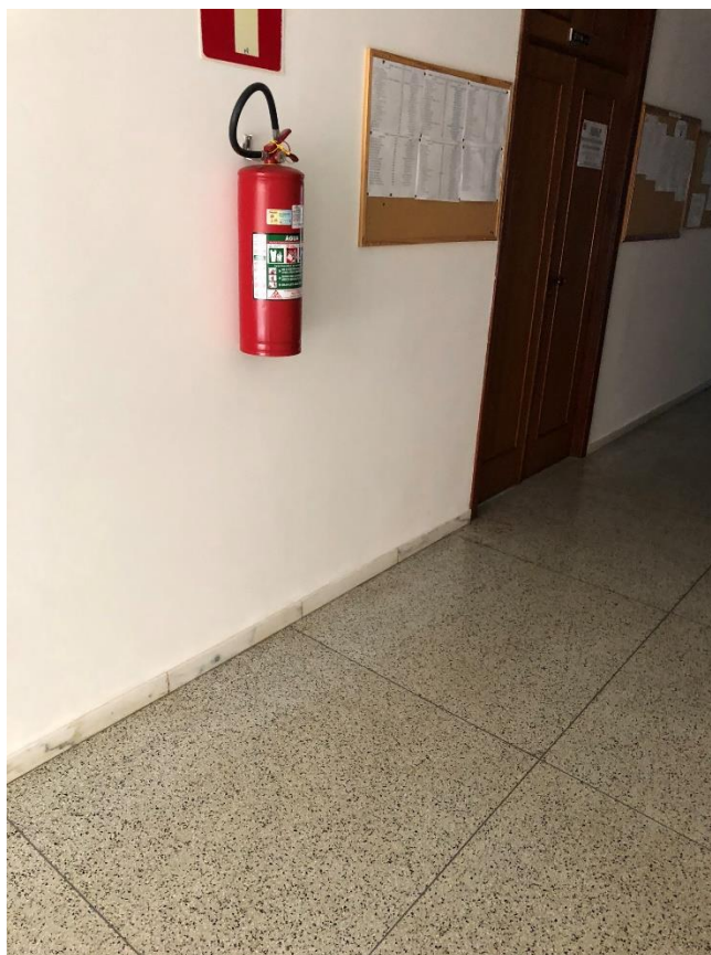
Figura 2 - MOBILIÁRIO NA ROTA ACESSÍVEL
