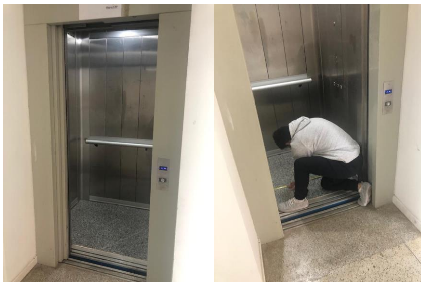
Figura 3 - ELEVADOR DO BLOCO 1
