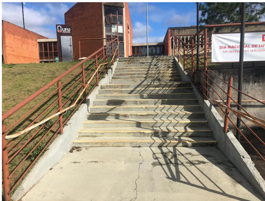
Figura 9 - ESCADA DE ACESSO DO BLOCO 5
