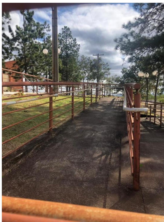
Figura 10 - TRECHO DA RAMPA DE ACESSO DO BLOCO 5
