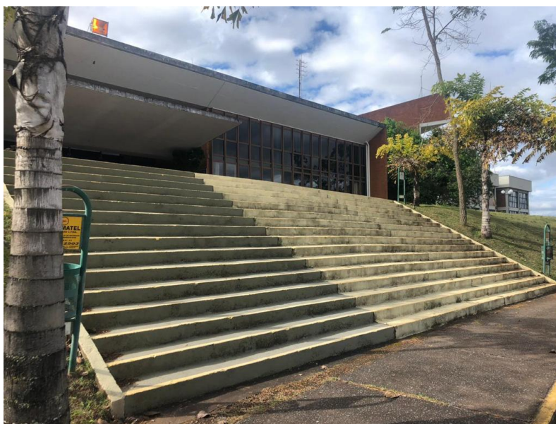
Figura 8 - ESCADA DE ACESSO DO BLOCO 1
